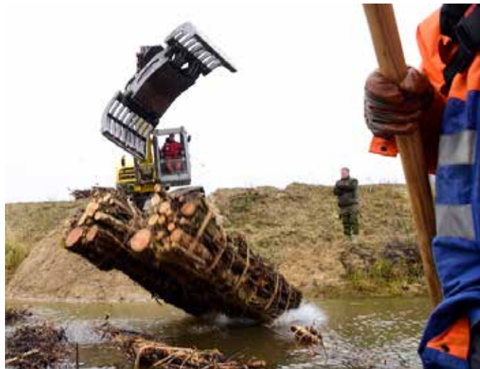
Der Totholzeintrag in den Collrunger See bildete den Auftakt der BAGGERSEE-Umsetzungsmaßnahmen. (© T. Klefoth / AVN e.V.)
