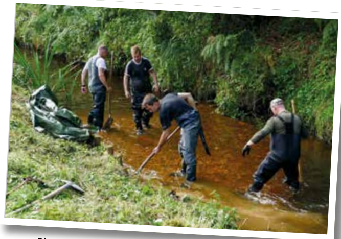
Die Kiesbank wird über die gesamte Bachbreite verteilt.
