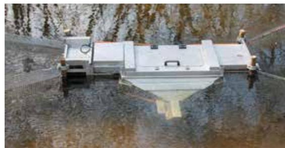
Der installierte Riverwatcher im Betrieb
