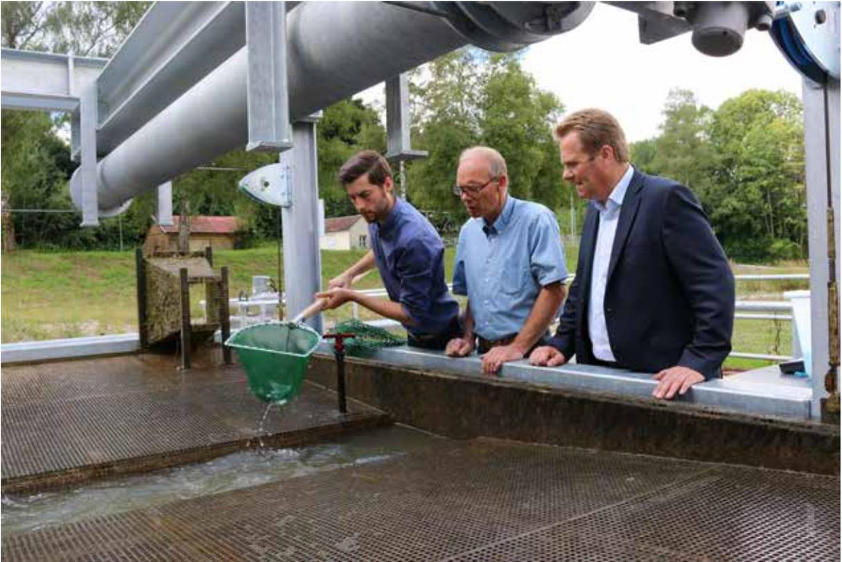
Abb. 2: Am oberen Ende der Fischwanderhilfe wurde ein Fischzählbecken installiert. Über eine Reusenkonstruktion müssen aufwandernde Fische in dieses einschwimmen. Das Fischzählbecken wird täglich unter Mitarbeit von Mitgliedern der Fischereivereine Memmingen und Neugablonz ausgewertet (v.l.n.r.: T. Eppele, Dr. O. Born, R. Klocke).
