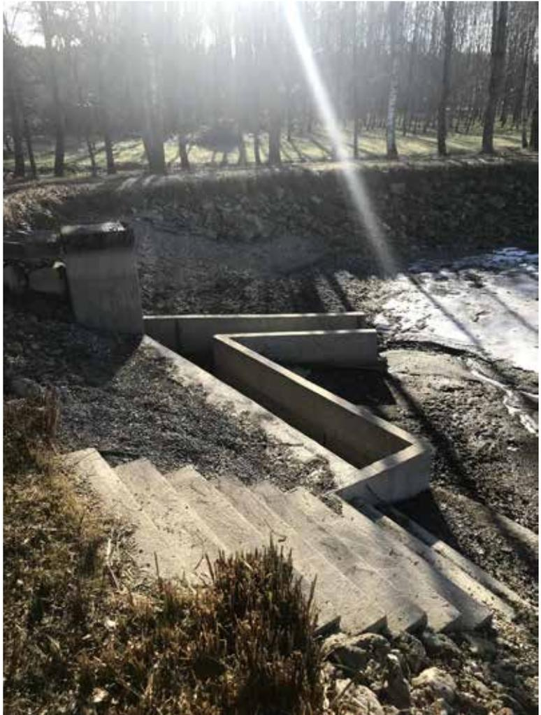
Abb. 7: Die Betonrinnenkonstruktion im Teich zum schonenden Abfischen der Nasen.
